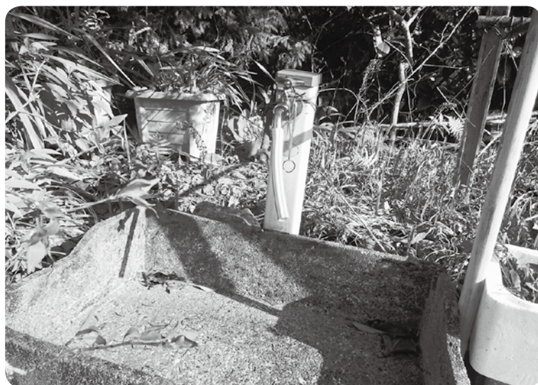
山間地の給水施設
