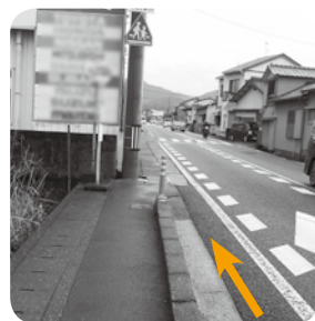
狭くて人が通るスペースがない
