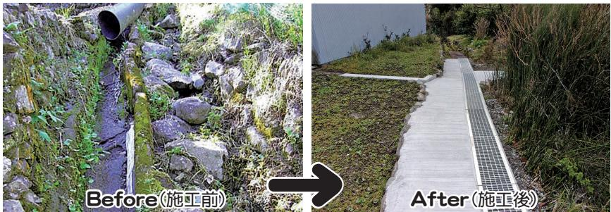
平井自治会(物部町)では、生活排水路の改修に補助金を活用しました。老朽化のため損壊し、隣のユズ畠にも被害を与えていた生活排水路をコンクリートで舗装しました。
