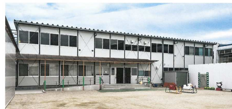
仮設幼稚園舎 建設地/愛知県名古屋市 商品/ダイワフラットL(DL/パネル) 延床面積/876m 2
