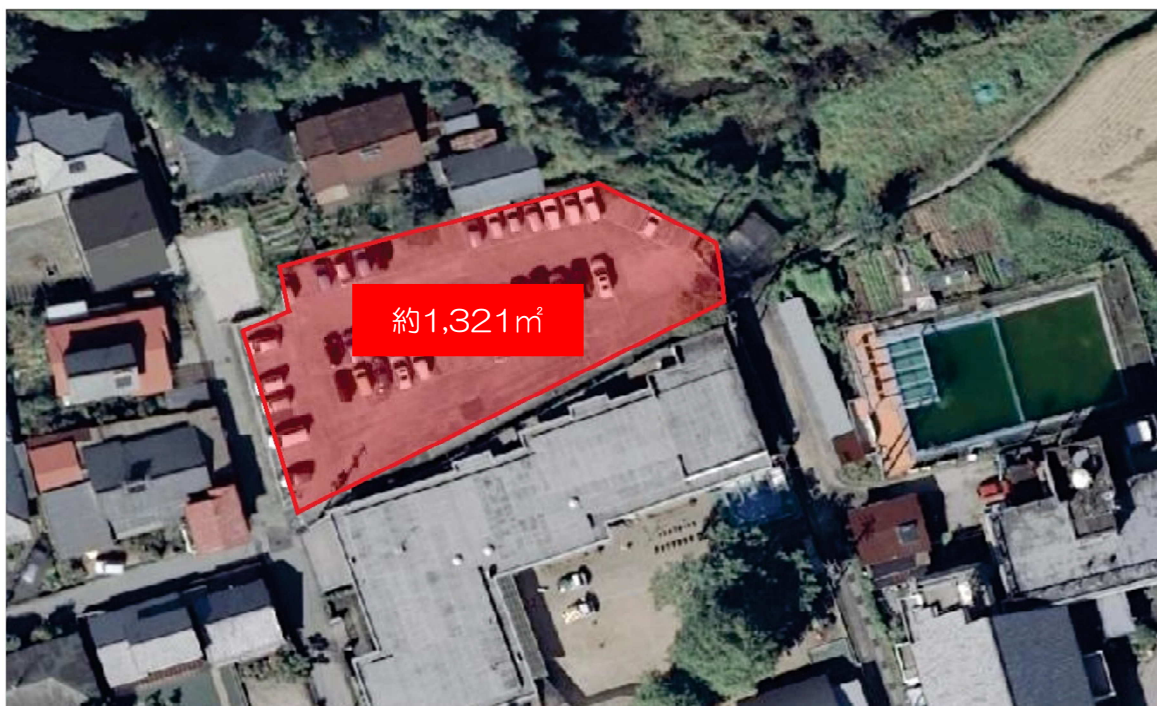
新園舎建設部分
