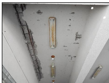
軒天コンクリート片の脱落・ 露筋
