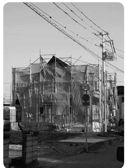
新築住宅の建設現場
