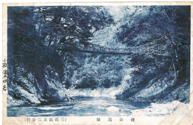
▲当時の横山葛橋(大桁葛橋)
