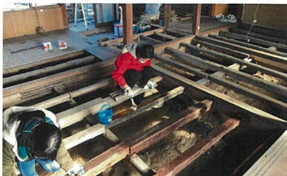
作業内容：束、大引、根太、床板の防蟻剤の塗布、畳の撤去
