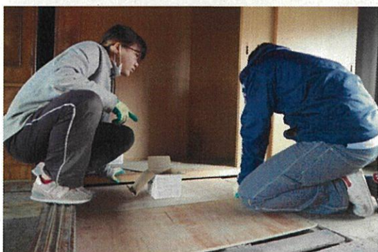
作業内容：差掛けの撤去、床張り
