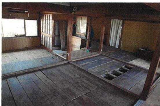
作業内容：束、大引、根太、床板の防蟻剤の塗布、畳の撤去
