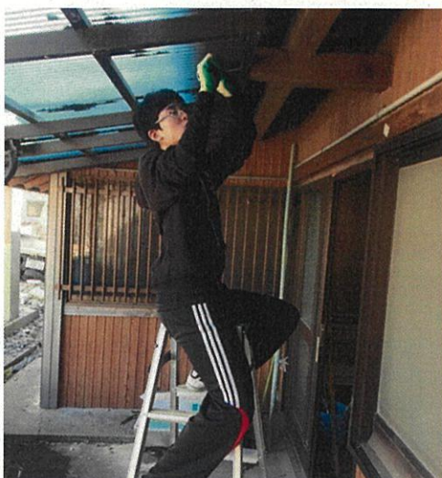
作業内容：束、大引、根太、床板の防蟻剤の塗布、畳の撤去
