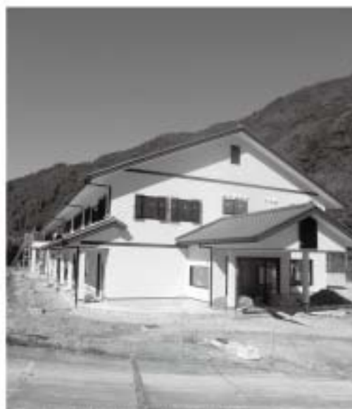
建設中の特養施設「葦生郷」(物部町)
