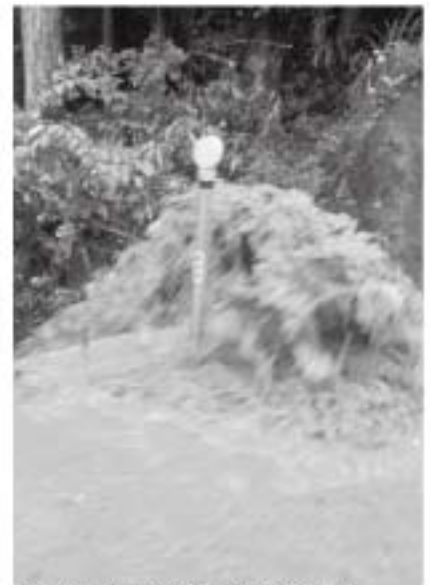
豪雨により道路にあふれる濁水
