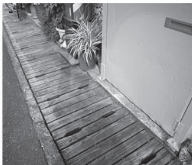
西本町1丁目商店街側溝
