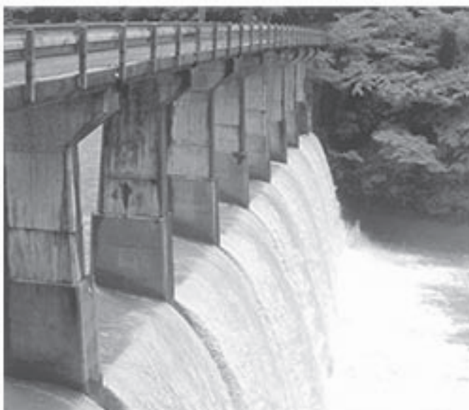
物部町安丸砂防堰堤
