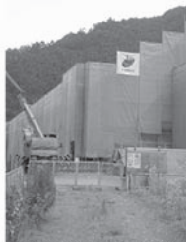
工事が進む特別養護老人ホーム「荘生郷」
