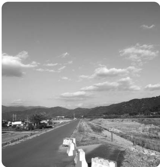
下ノ村地区の引堤
