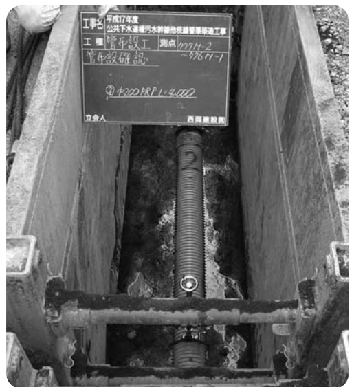
下水管設置工事
