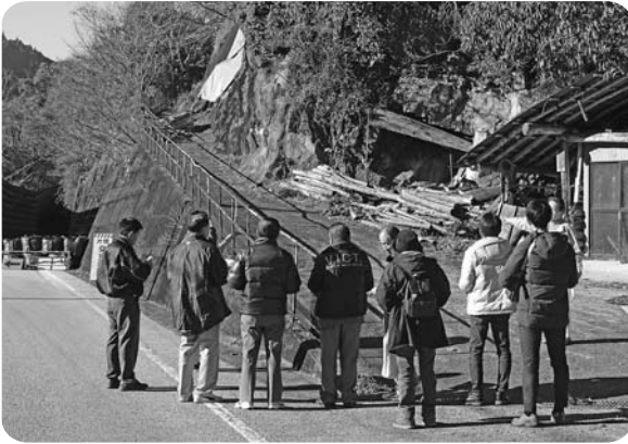
①佐岡トンネル出口付近(山腹崩壊)
