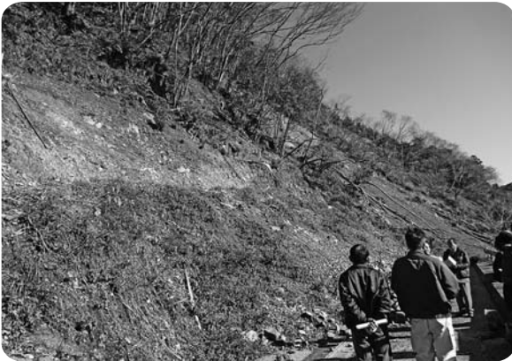
③須賀井トンネル付近(山腹崩落)
