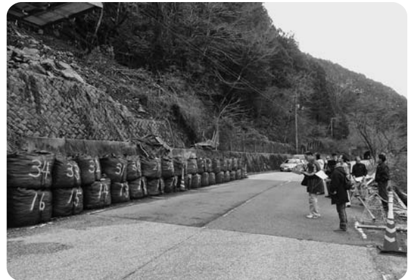
④檜山トンネル入口付近(山腹崩壊)
