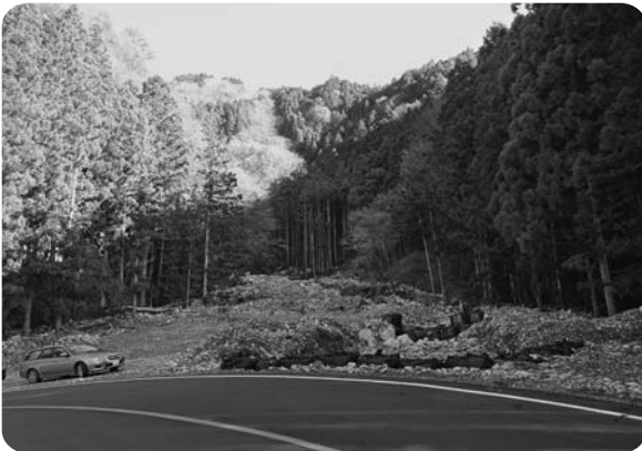
⑤国道195号と行者谷川との交差点部(路側崩壊)
