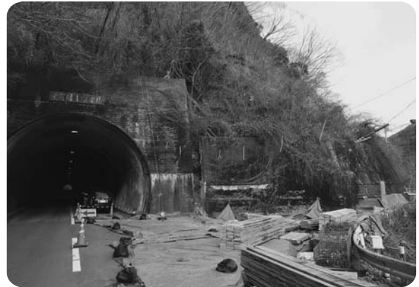
②須賀井トンネル入口付近(路側崩壊)
