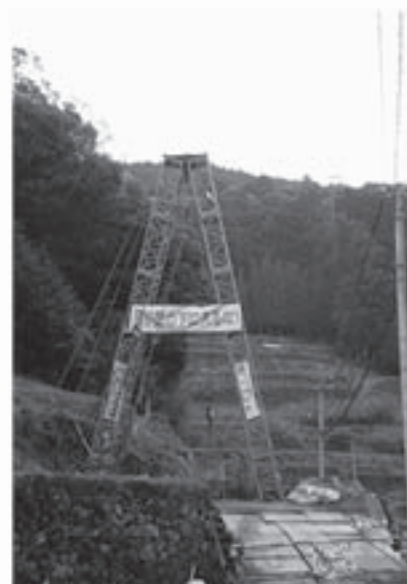
蘭水影山配水池整備工事
