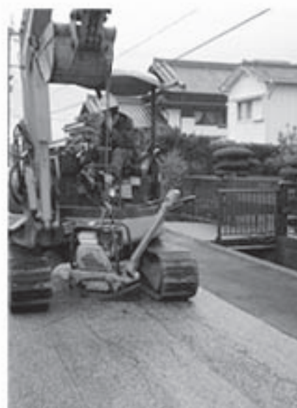
公共下水道北部分区工事
