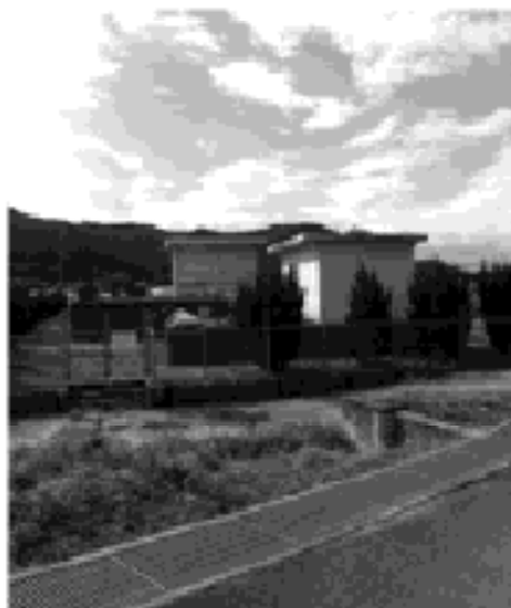
水道施設（山田島水源地）
