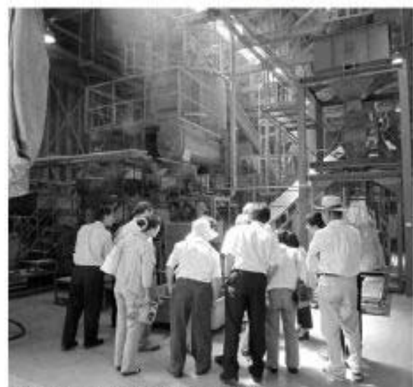
木質バイオマス視察（栲原町にて）
