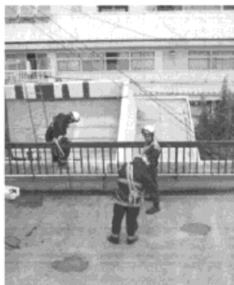
旧庁舎解体を利用して防災訓練
