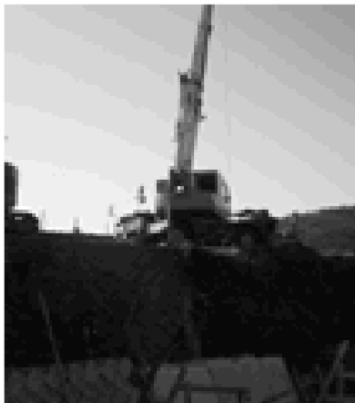
地元業者による土木工事
