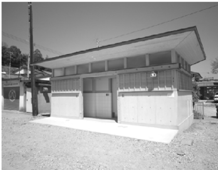
新装になった八王子トイレ
