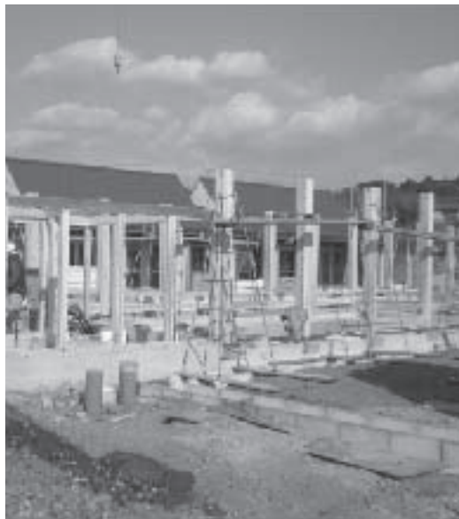
「あけぼの保育園」建設工事
