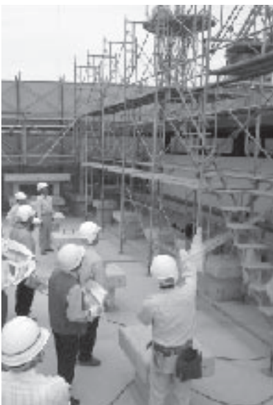
庁舎建設(屋上)
