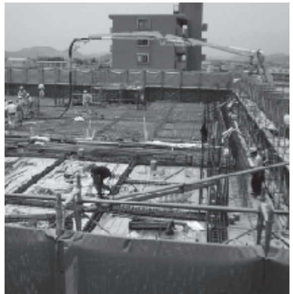
新庁舎建設工事
