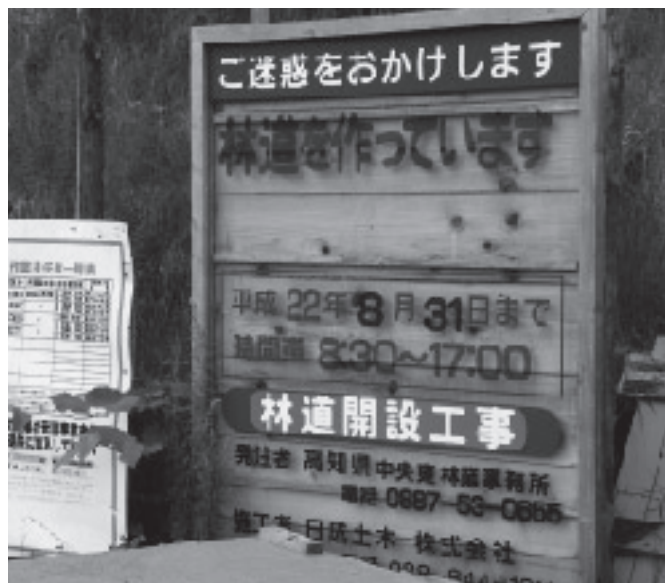
林道河口落合線開設工事
