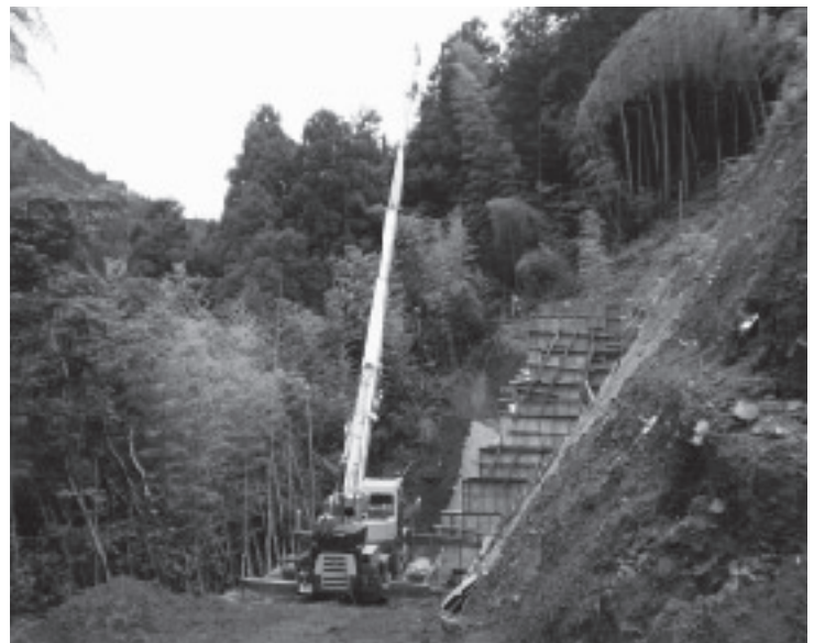
道路改良工事・西後入線
