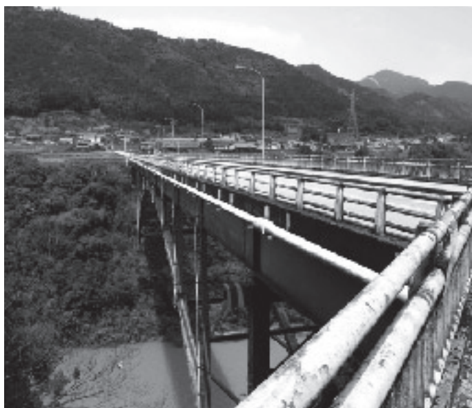
塗り替えが望まれる新在所橋
