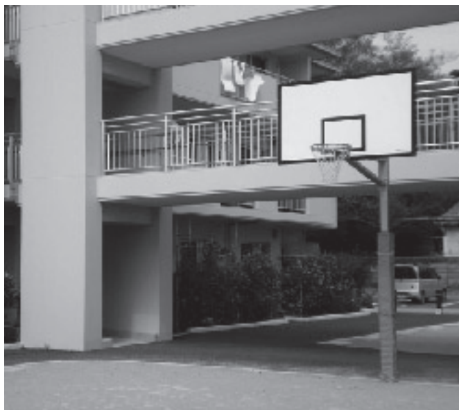
防球ネット設置が望まれる
