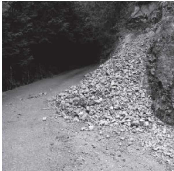
小崩落した林道
