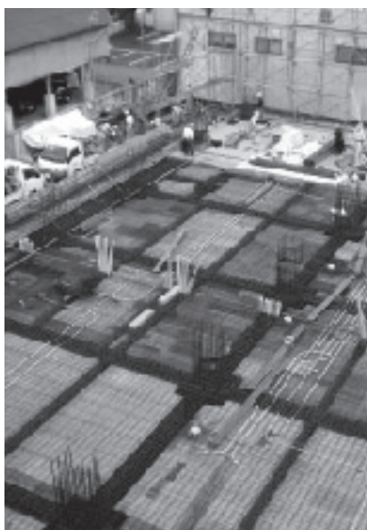
新庁舎建設工事
