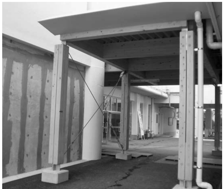
地元業者により、耐震工事完了・山田小学校
