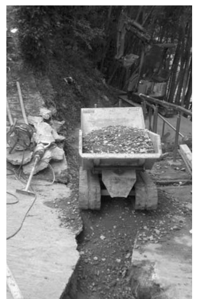
下水道工事・逆川地区
