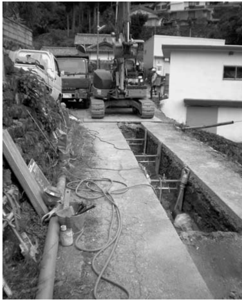
下水道工事・逆川地区
