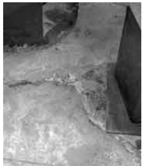
納屋内のクラック(白石地区)
