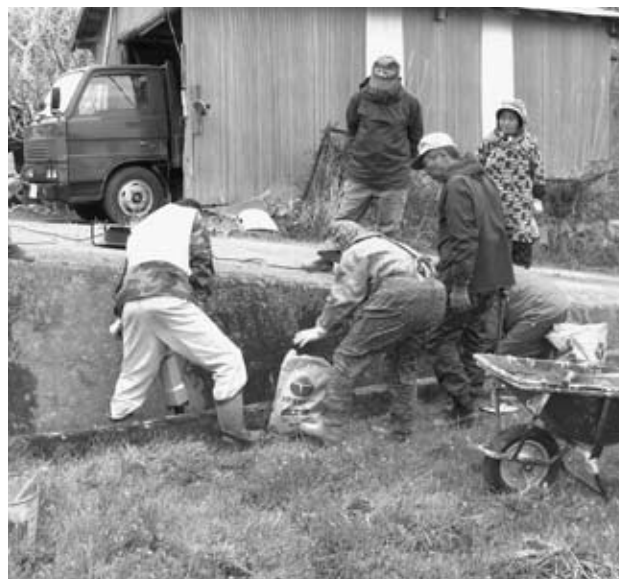
協同作業(水路改修)
