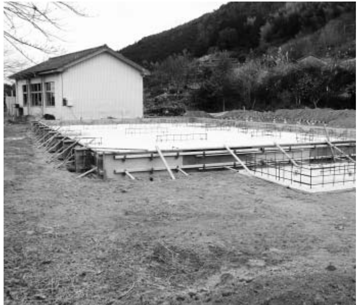
三谷地区集会所建設現場
