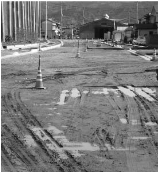
工事が進むあけぼの街道
