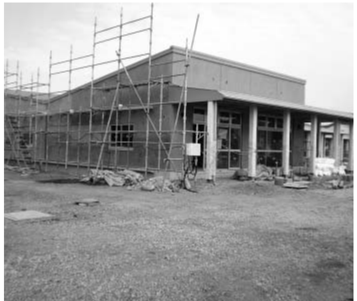
建設中のなかよし保育園
