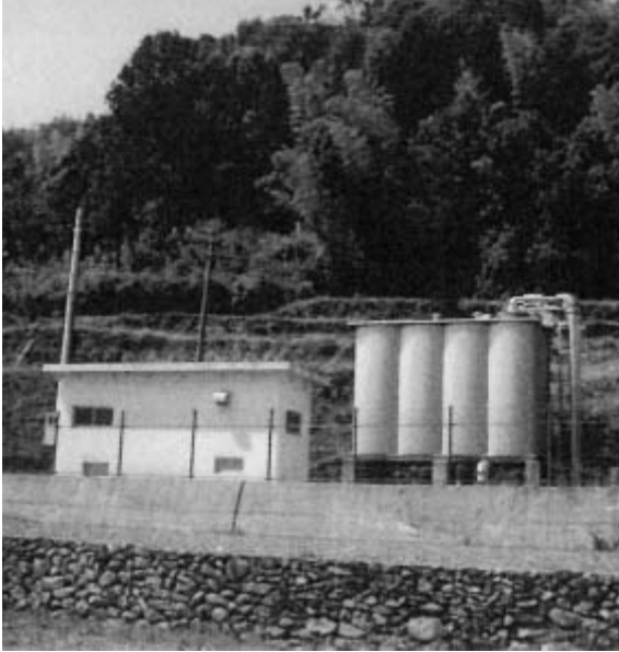
簡易水道施設
