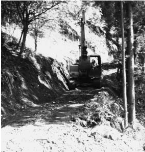
公共土木工事
