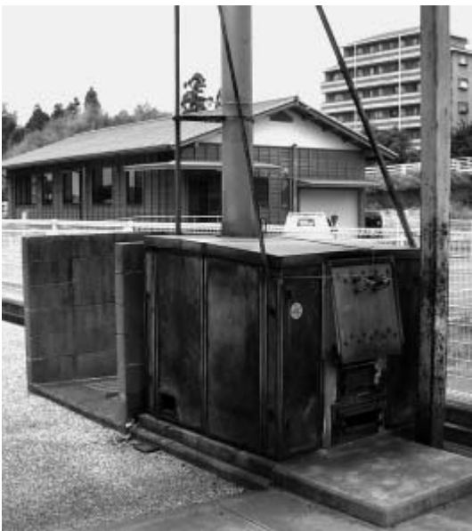
未撤去の小学校焼却炉
