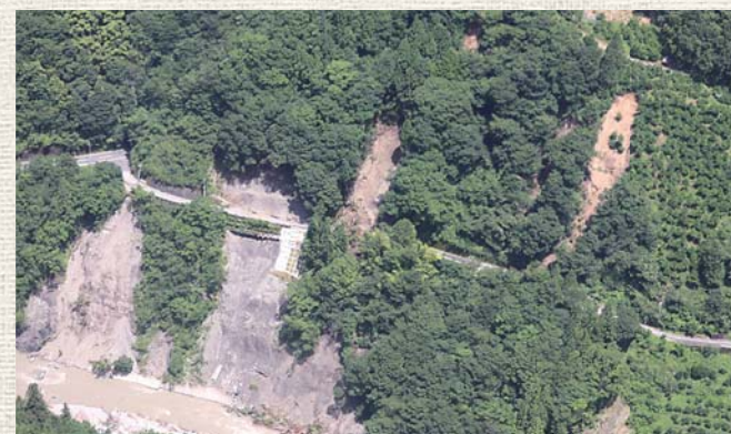
▲上空から撮影した須賀井トンネル(R195)付近の崩落
