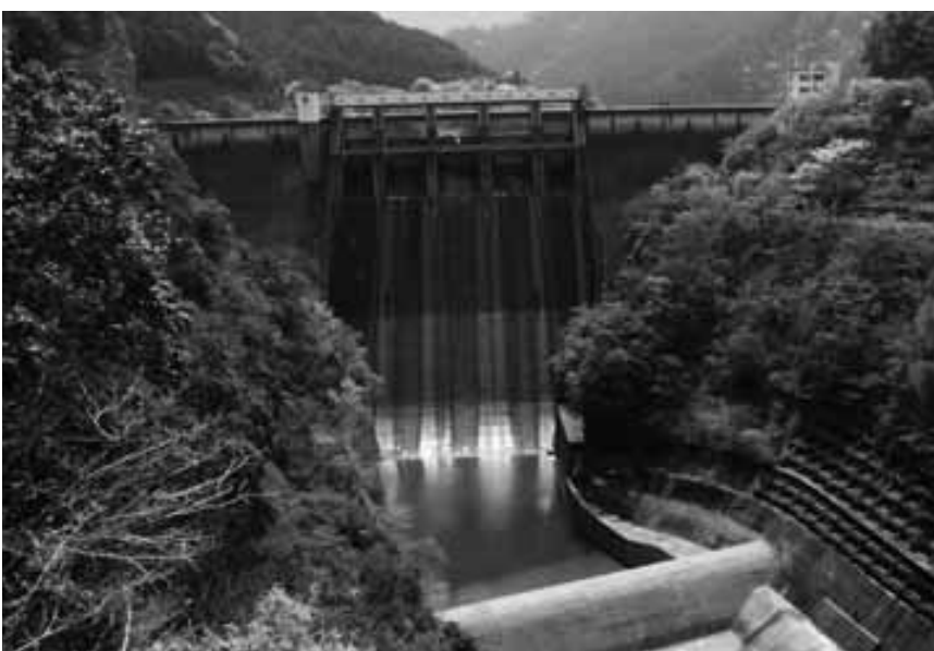
急がれる濁水防止対策（永瀬ダム）
