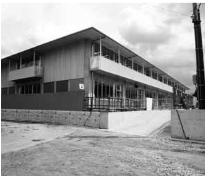
改築の進む大宮小学校
