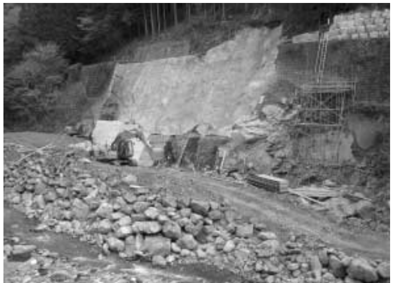
復旧工事(物部町)
