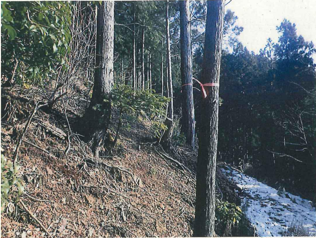
③ 作業道を付け替える予定地
