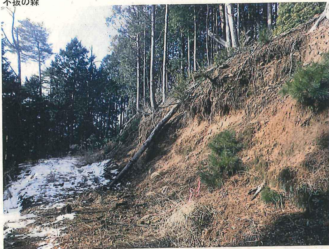
① 市有林内の作業道終点付近 (赤テープの地点から既設作業道に隣接する形で北側へ作業道を付け替えたい)
