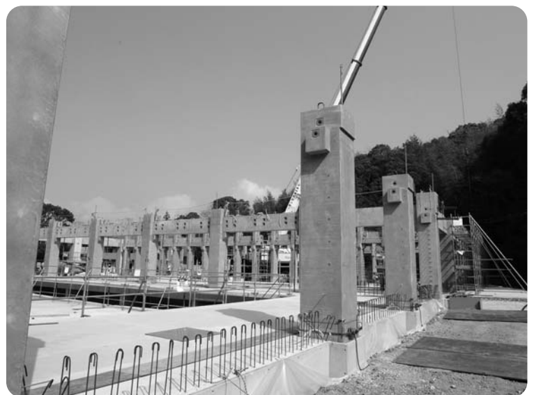
鏡野中学校武道館・プール基礎工事
