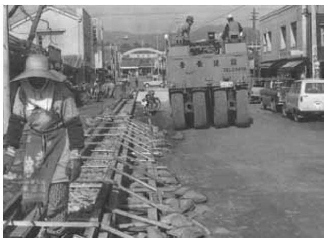
2-1 昭和40年 駅前舗装工事
