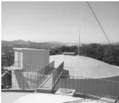
八王子配水池
