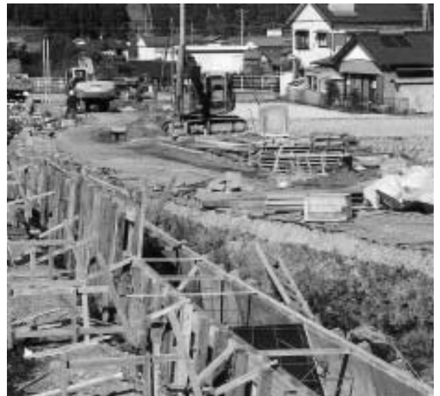
市道拡幅工事（香北）
