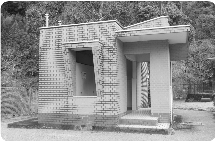
日ノ御子河川公園トイレ
