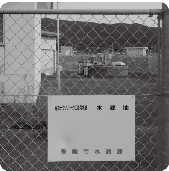
工業用水取水施設
