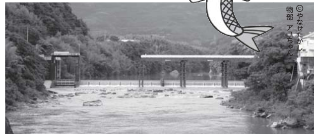
▲仮橋がかけられた物部川合同堰(8月15日撮影)
