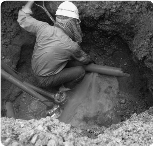
水道管の修繕
