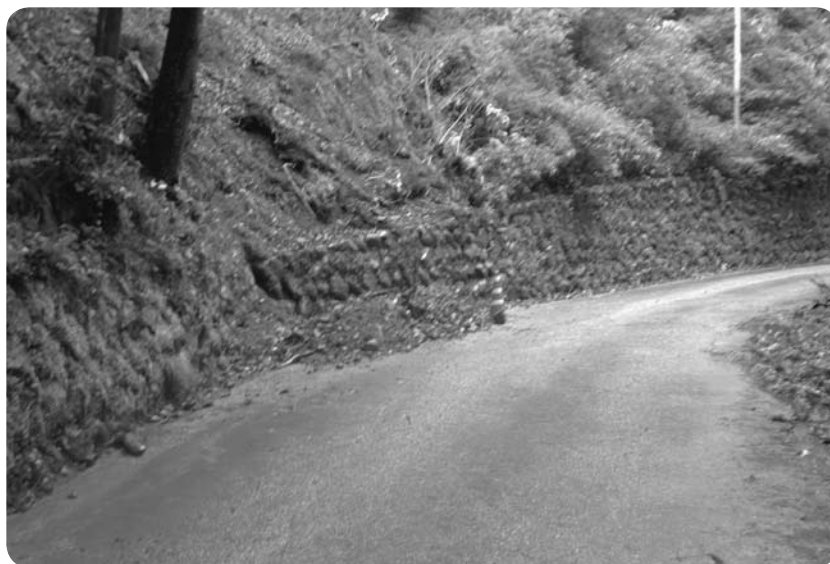
林道・亀ヶ峠線 (物部町)
