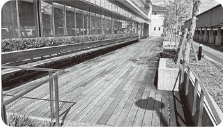
本庁舎ウッドデッキ
